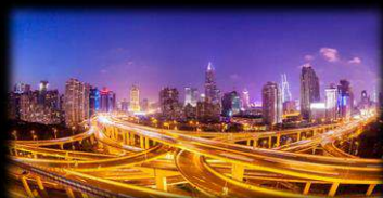
インフラ Infrastructure
